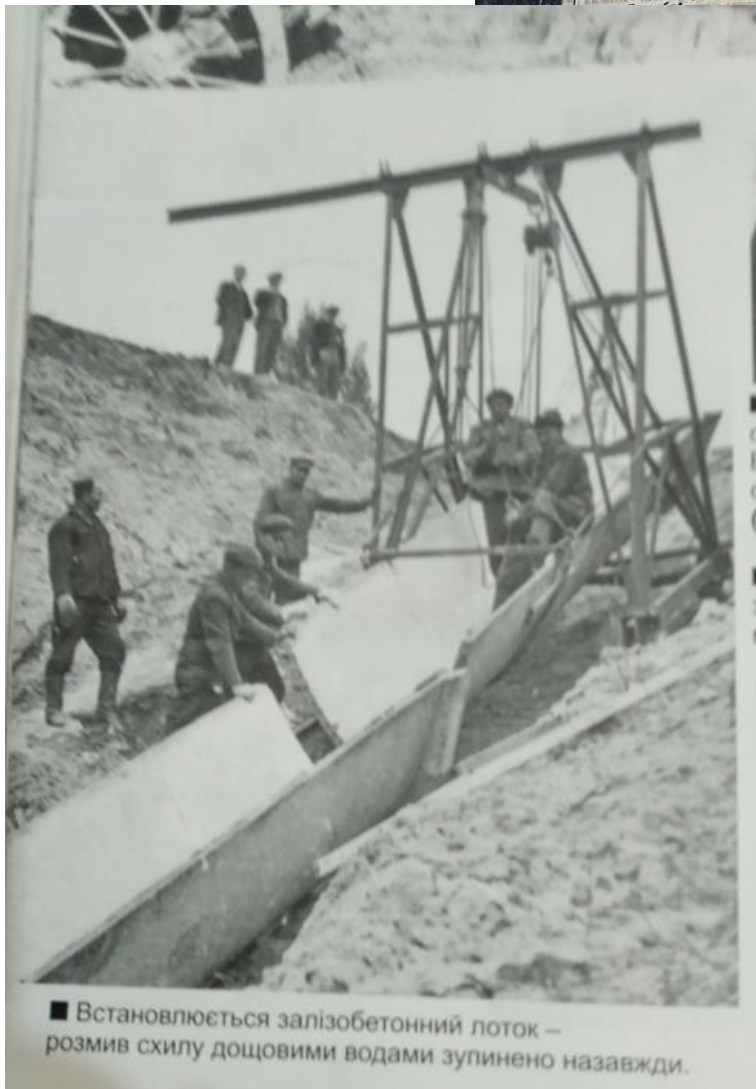
Фото 4. Встановлення водостоку
